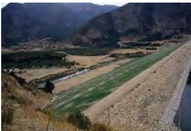
Foto 19. Vista superior del muro de contención del tranque de relaves
