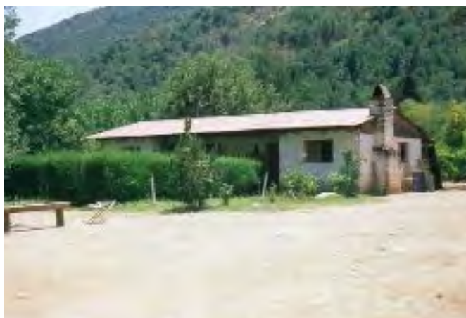
Foto 26. Casa de trabajadores del convenio CONAF-Teniente, aguas arriba del tranque de relaves
