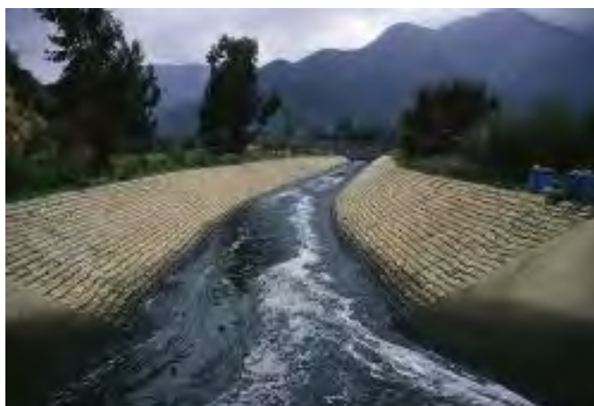
Foto 22. Cauce artificial para aguas claras provenientes del relave
