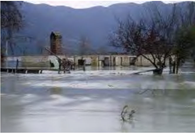
Foto 37. Sector casa 18. Antigua estructura de la hacienda, hoy cubierta parcialmente por el relave
