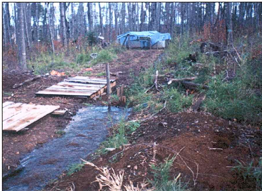
Foto 2: Canal abastecedor, toma de agua y estanque acumulador.
